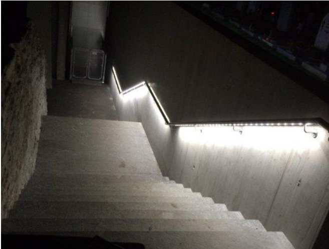
Fertige Treppenbeleuchtung Friedhof Glis
